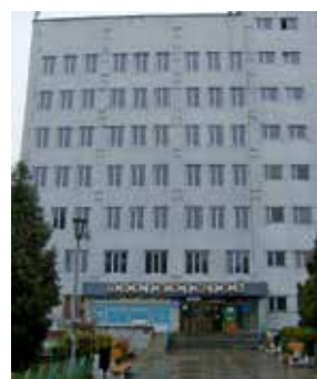
Diagnostisk bygning, laboratoriet ligger på 3. sal i 2 små lokaler.
